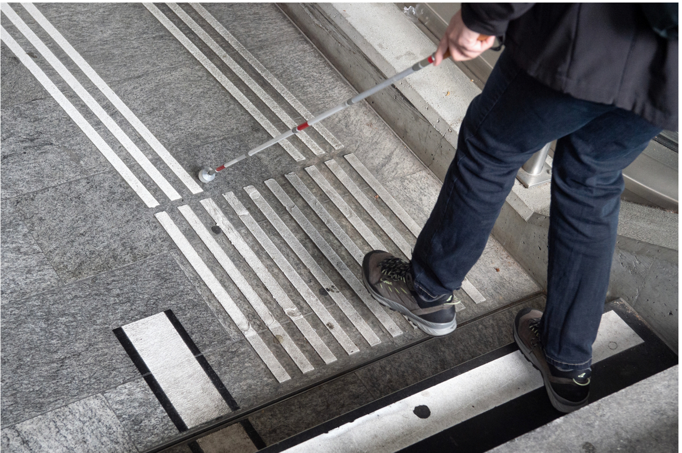
Bahnhof Chur: Die Leitlinien sollen für sehbehinderte und blinde Personen zugänglich sein.
